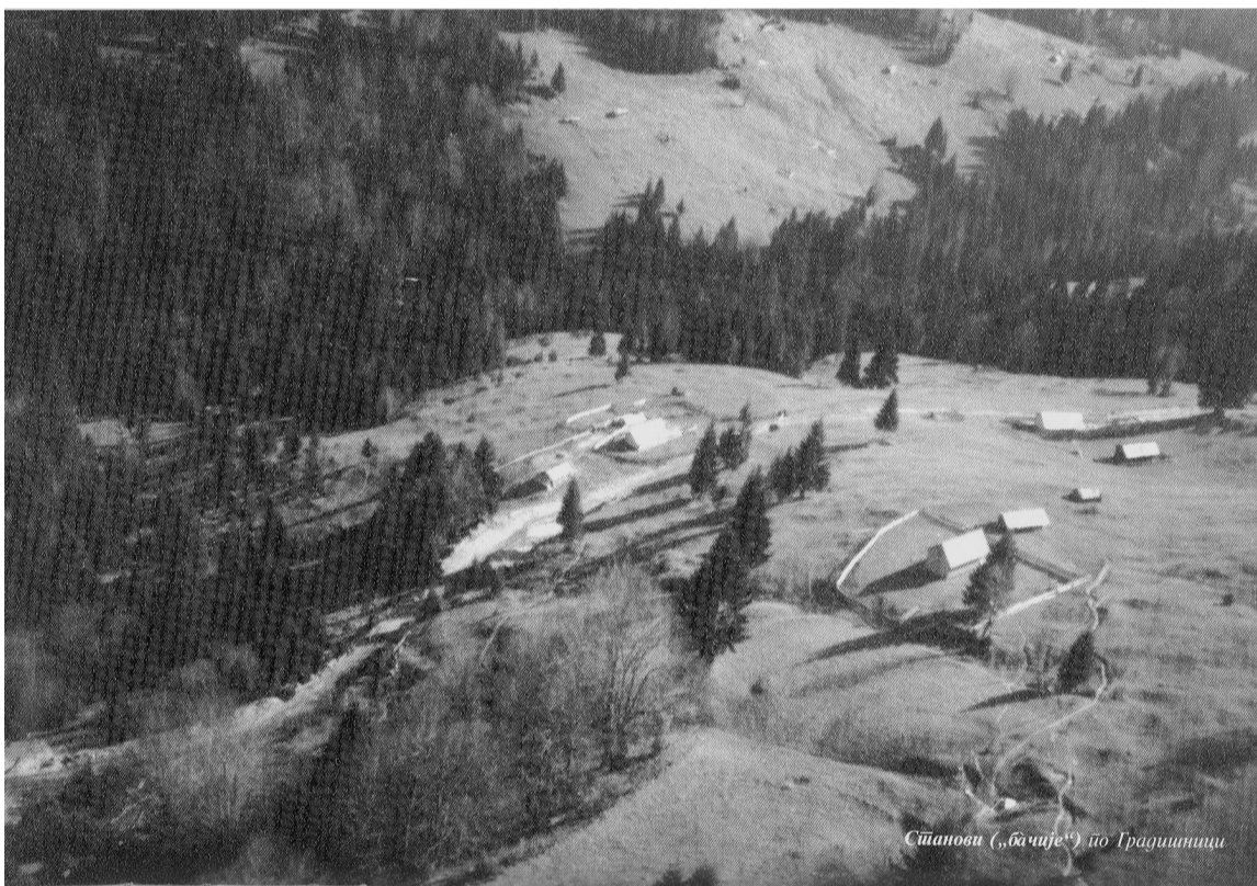
Станови (“бачије”) на Градишници I
